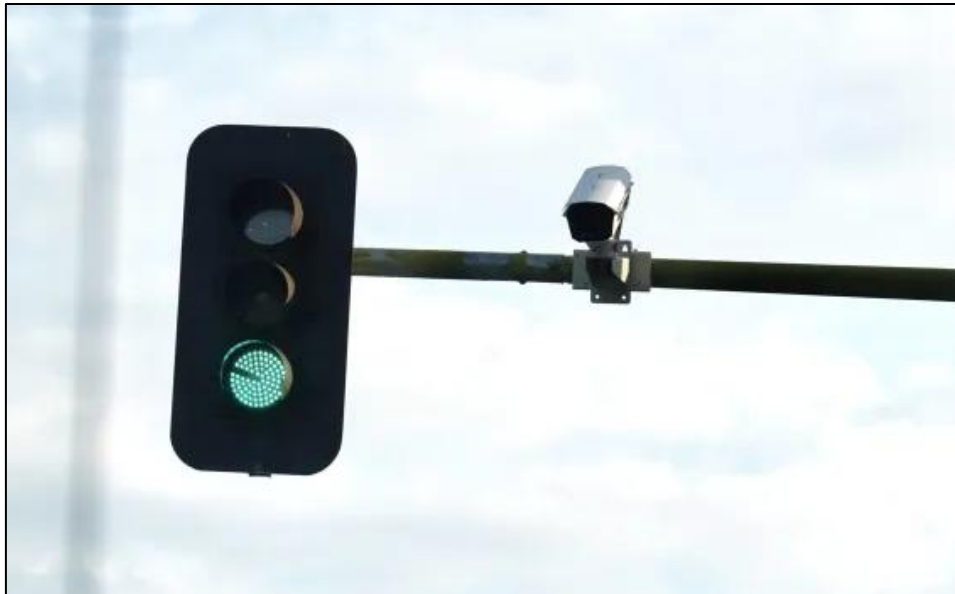
Ilustración 31. Cámaras de videovigilancia instaladas en semáforos de Alcorcón.
