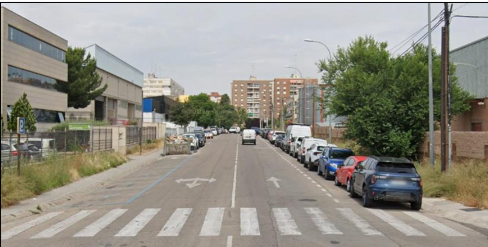
Ilustración 28. Aceras inaccesibles (ancho < 1,8 m) en Calle de las Fábricas.
