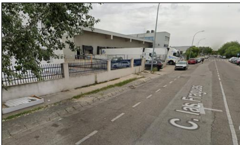
Ilustración 12. Calle Las Fraguas Ancho deficiente en aceras.
