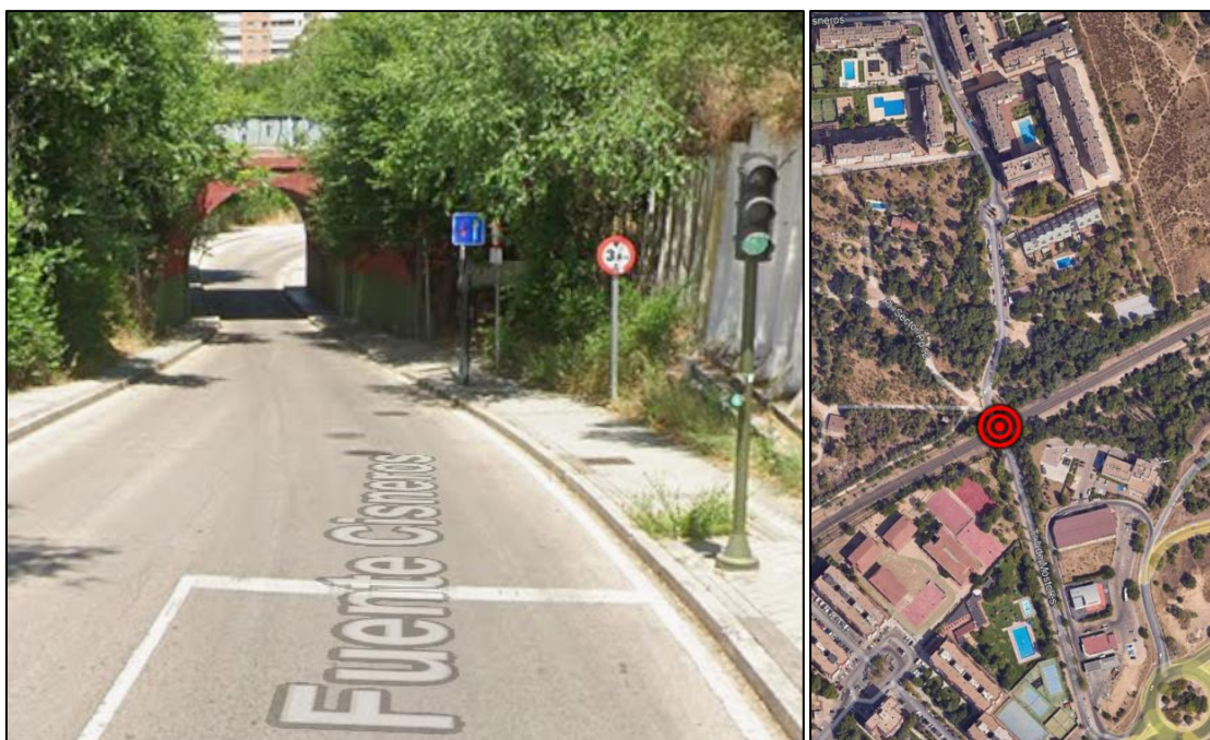
Ilustración 8. Situación actual de la Travesía Móstoles en su paso inferior con la vía del tren en la entrada a Fuente Cisneros. Fuente: Google Street View.
