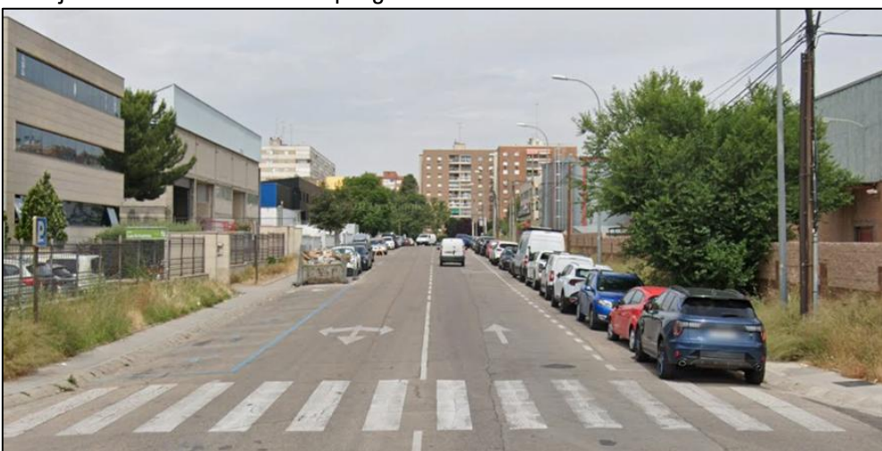
Ilustración 28. Aceras inaccesibles (ancho < 1,8 m) en Calle de las Fábricas.
