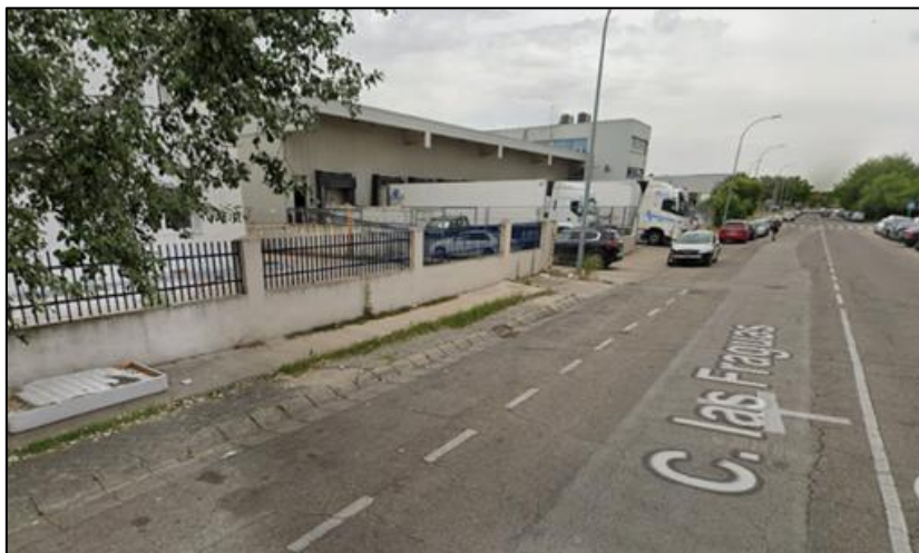
Ilustración 12. Calle Las Fraguas Ancho deficiente en aceras.
