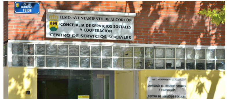
Uno de los centros de Servicios Sociales que se remodelará
