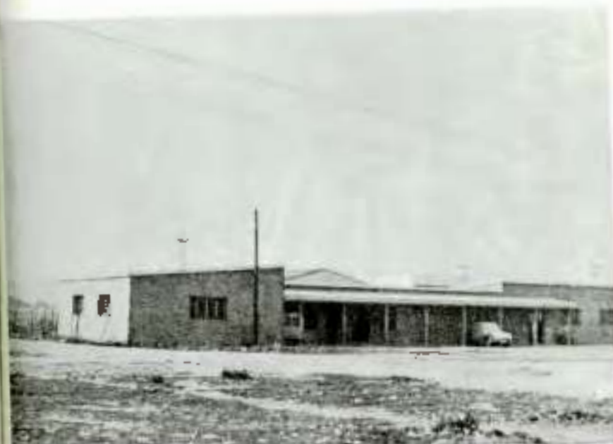
La Escuela de Formación Intensiva Profesional, una más de las admirables aportaciones de Constructora Peninsular, hoy Promotora de Cooperativas y Comunidades, S. A., al progreso de Alcorcón. Está ubicada en San José de Valdearas
