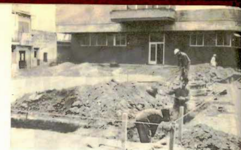
Día 7.—Comienzan las obras de pavimentación y ornamentación de la plaza del Ayuntamiento, que se valoran en 2.300.000 pesetas.
