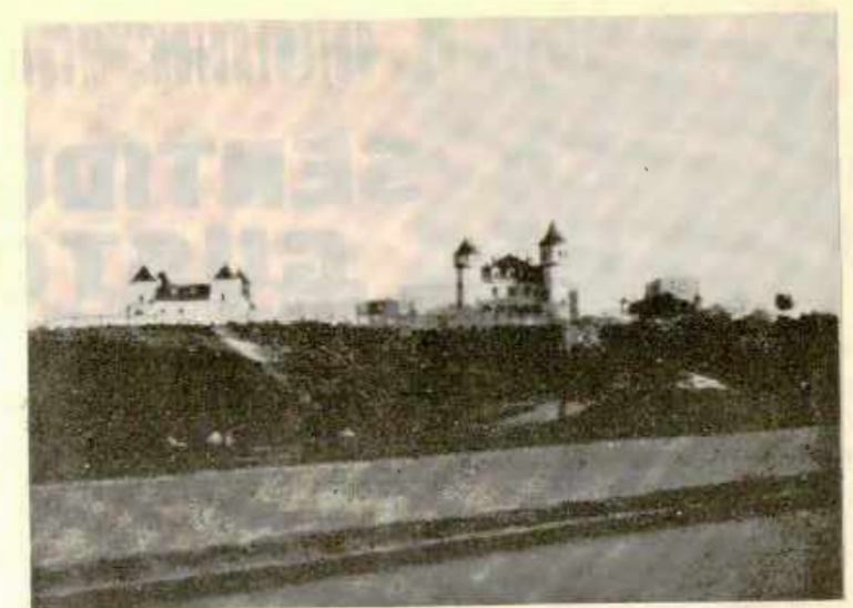
Arriba, los dos castillos o palacios vistos de lejos; en el centro, las fachadas sur y norte del castillo principal; abajo, a la izquierda, el palacio del oratorio y, a la derecha, el edificio alojamiento de la servidumbre
