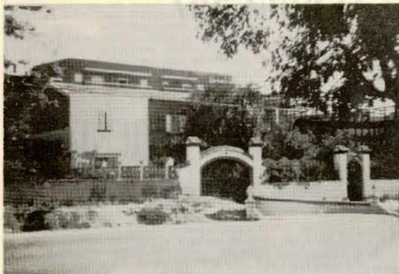
Fachada de la casa del Instituto en Alcorcón
